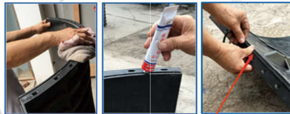
均匀按压挤入槽内 安装密封条
